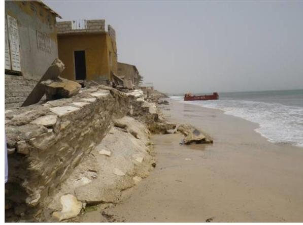
Photo : 4 protections de type ouvrage longitudinal en enrochements à Bargny
